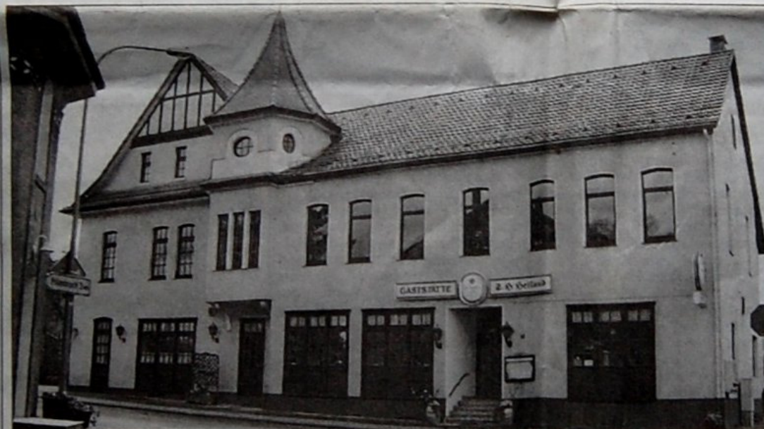
46 Jahre nach der obigen Postkartenaufnahme hat sich das Gasthaus Hetland erneut verändert. Inzwischen befindet sich kein Gemischtwarenladen mehr in dem Gebäude. Seit 1974 fungiert das Haus auch als Hotel.
